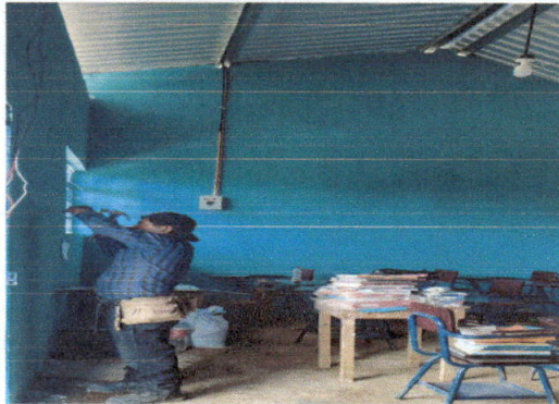
Foto1: reparación de sistema eléctrico
