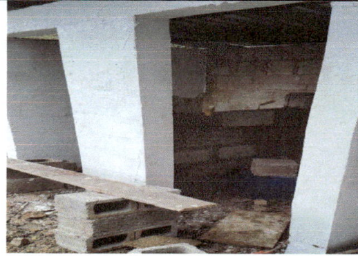
Foto 2: remodelación de los baños
