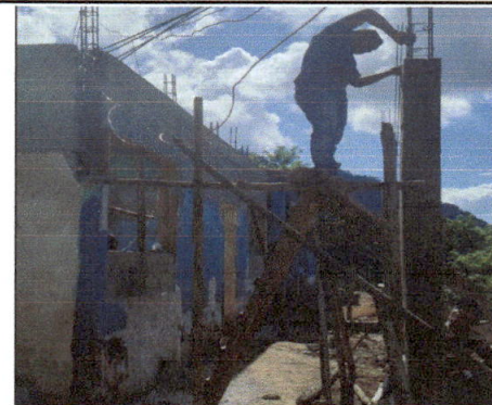
Foto 4: rehabilitación de pared
