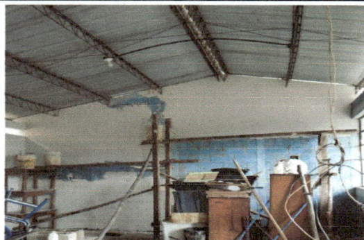
Foto 5: repellar con monocapa, todos los edificios
