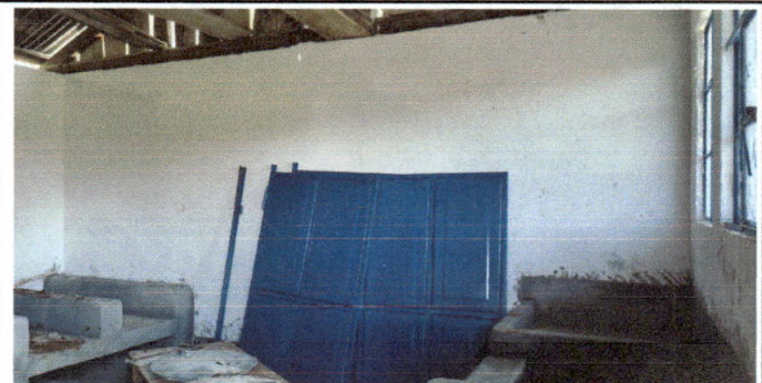
Foto 6: cambio de piso rajadas y mantenimiento a la pared
